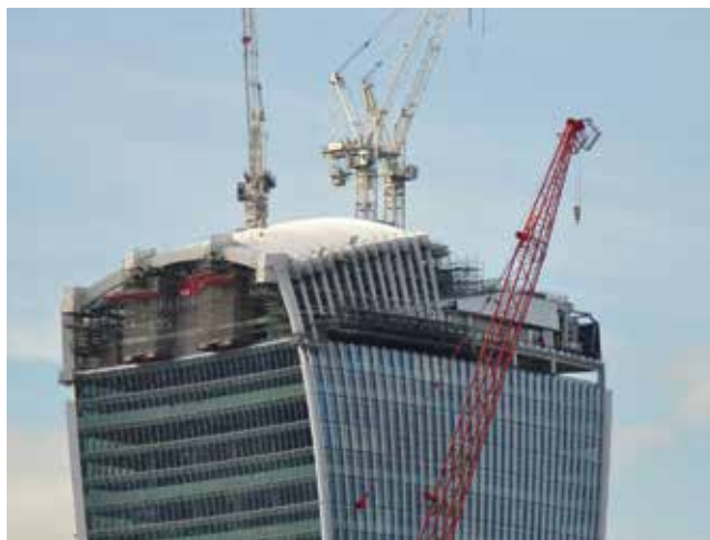
9. kép: Sky Garden keretállások építés közben
