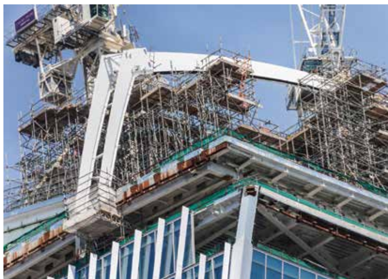
8. kép: Sky Garden első keretállások szerelése
