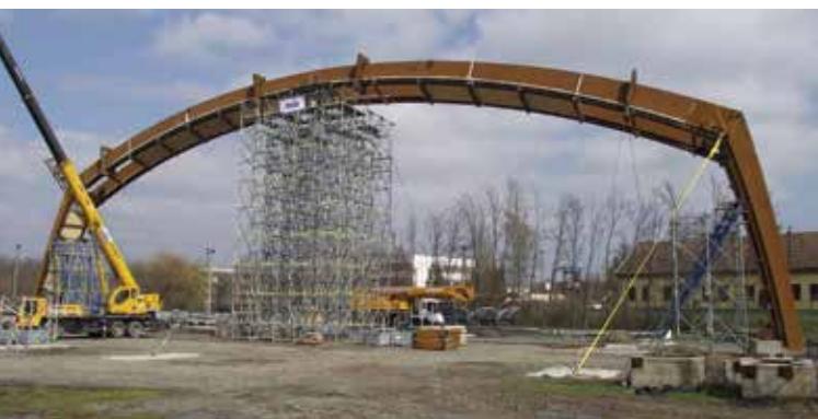
6. kép: A 7. és 8. keretállások próbaszerelésének ellenőrzése
