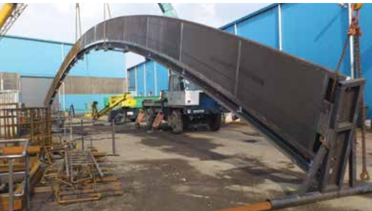
5. kép: Tetőgerendák összeépíthetőségének ellenőrzése
