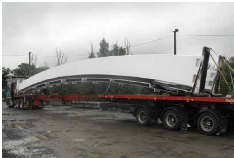
7. kép: A 23,7m-es tetőgerendák szállítása
