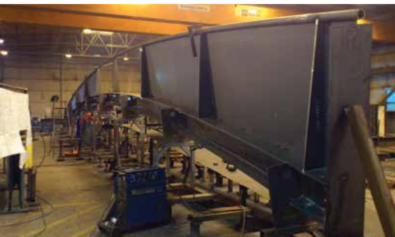
3. kép: Tetőgerenda borítólemezének felhelyezése
