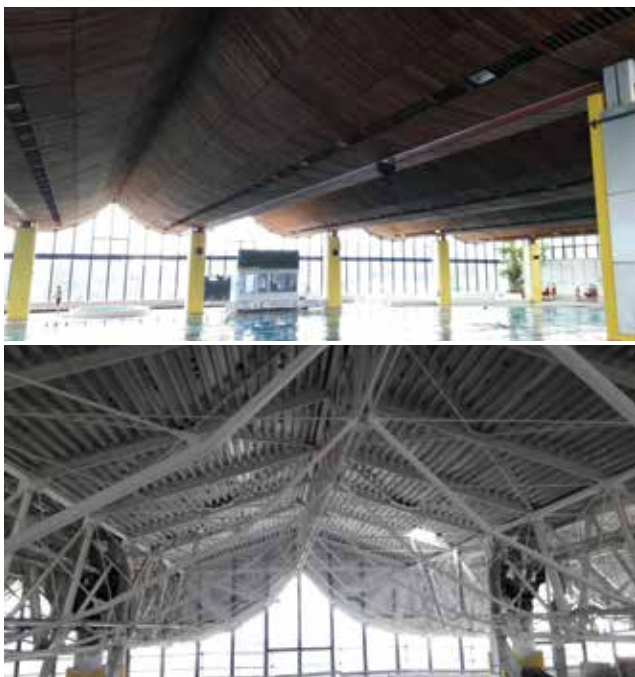
3. kép: A szombathelyi uszoda rekonstrukciója – tetőszerkezet és burkolattartó rendszer (burkolattal és nélküle)
