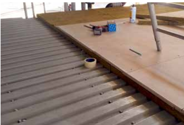
9. kép: STW20 alacsonybordás trapézlemez teherhordó födémlemez funkcióban
